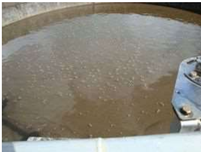
Figure 2.3 - Bassin d'aération zone d'anoxie centrale
