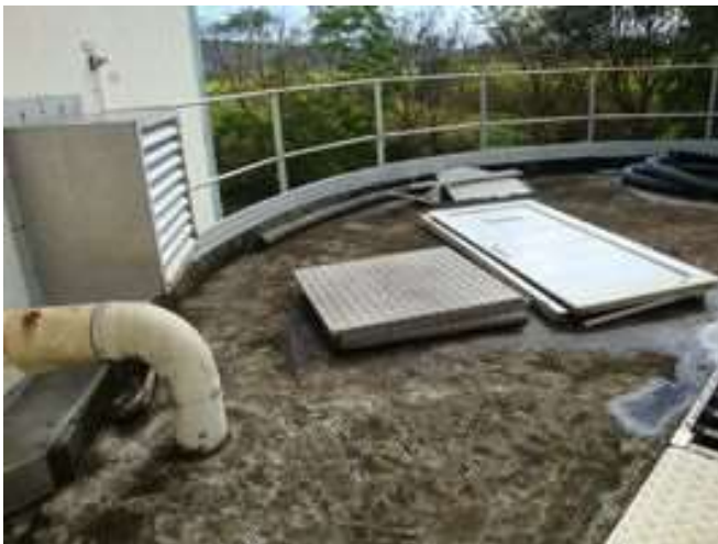
Figure 2.2 - Dessableur dégraisseur
