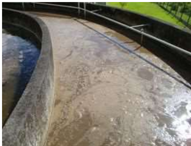
Figure 2.4 - Bassin d'aération zone d'aération périphérique
